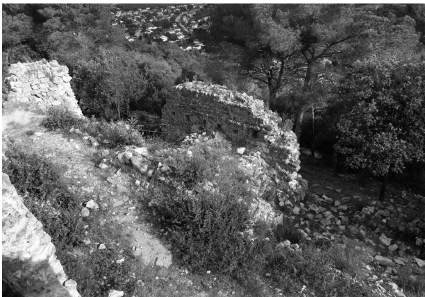
Vista de l'estat de l'interior de les dependències del castell abans de la intervenció de 2017-2018. Foto: Josep M. Vila.
