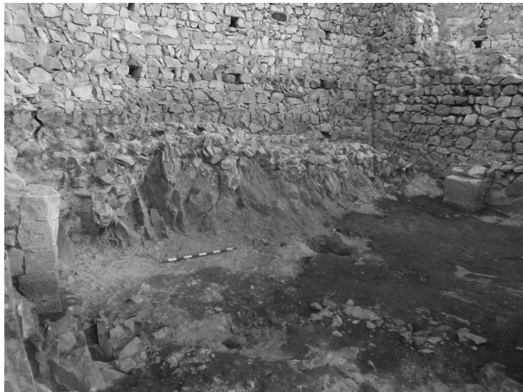
Vista de la sala principal del castell, amb els arrencaments de l'arc central de diafragma que servia per sostenir la coberta de la sala. Foto: Cristina Belmonte.
