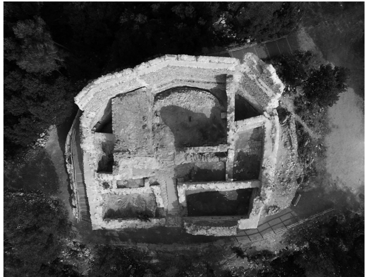
Vista aèria del castell un cop finalitzada la intervenció de 2018. Foto: Ajuntament de Bigues i Riells.
