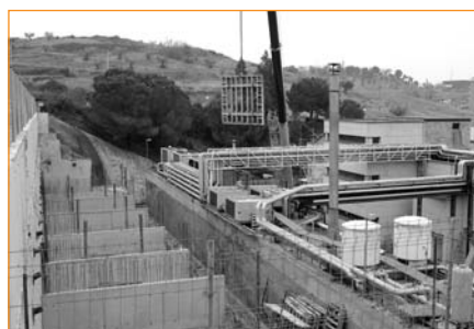
Construcció del nou edifici d'instal·lacions
