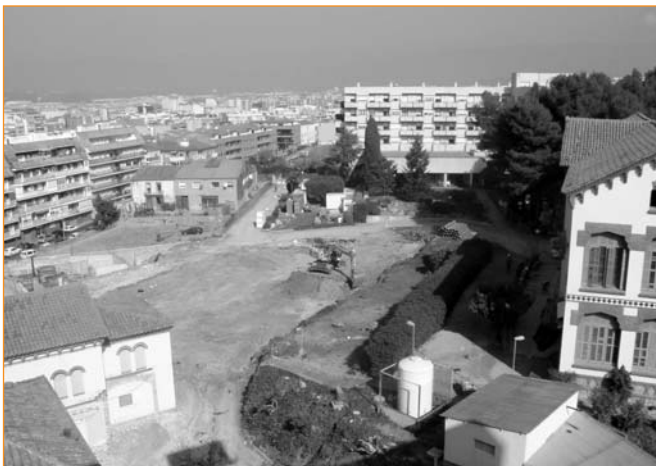
En aquest solar s'ubicarà el nou edifici de consultes externes
