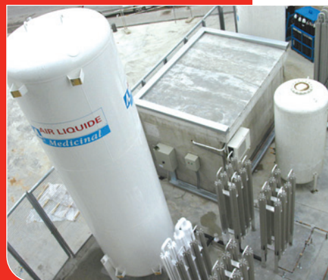
Nova instal·lació de gasos medicinals
