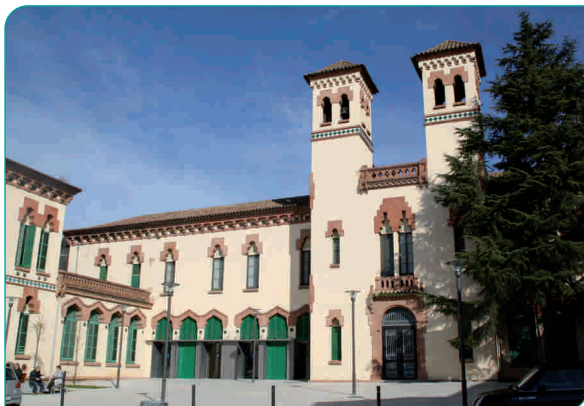
Façana del nou edifici de consultes externes de la FHAG
