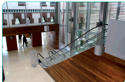
Imatge de les escales que pugen a la primera planta del nou edifici
