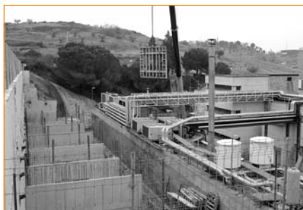
Construcció del nou edifici d'instal·lacions
