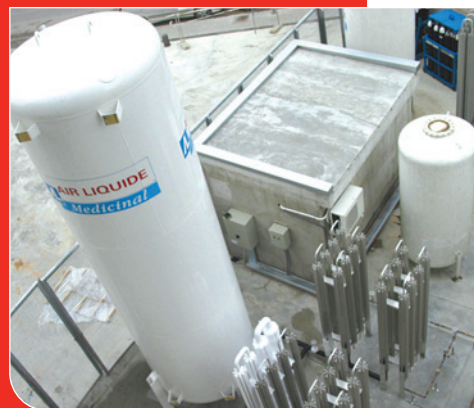
Nova instal·lació de gasos medicinals
