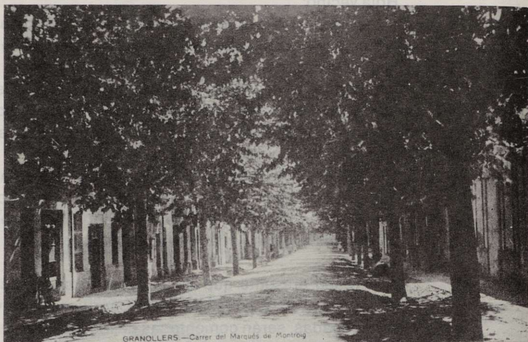
GRANOLLERS.—Carrer del Marquès de Monroig
