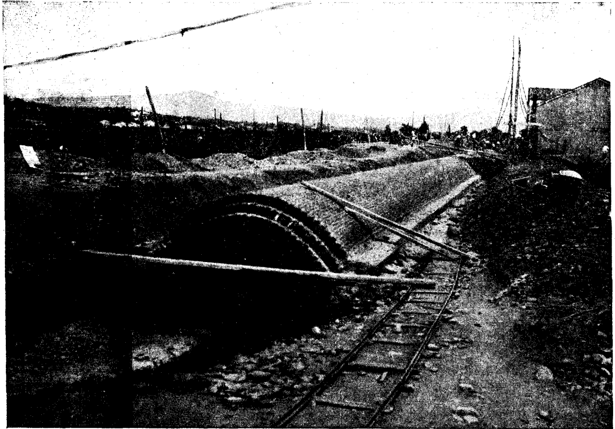
Heus-ací la divisa de tots els granollerins. La primera embranzida ha estat donada. Vegi's per les presents fotografies la importància que tenen les obres realitzades en el primer tros de col·lectora general. Ara, solament falta, l'esperit necessari de continuïtat.
