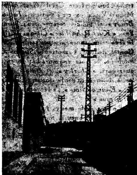
El carrer Ramon Llull, amb les pilastres de la línia d'alta tensió al mig de la calçada.
