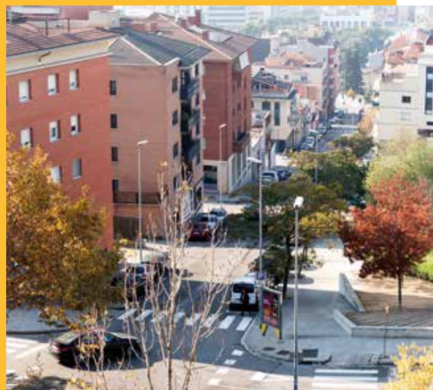
Les rampes que es construiran al carrer de Carles Riba, entre els carrers de Lluís Vives i de Veneçuela, al barri de la Font Verda, facilitaran la mobilitat en aquest carrer que té pendents que oscil·len entre el 10 i el 12 %
