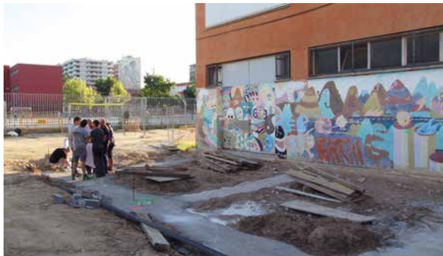
Obres d'ampliació i reforma del taller de mecanització de l'institut EMT
