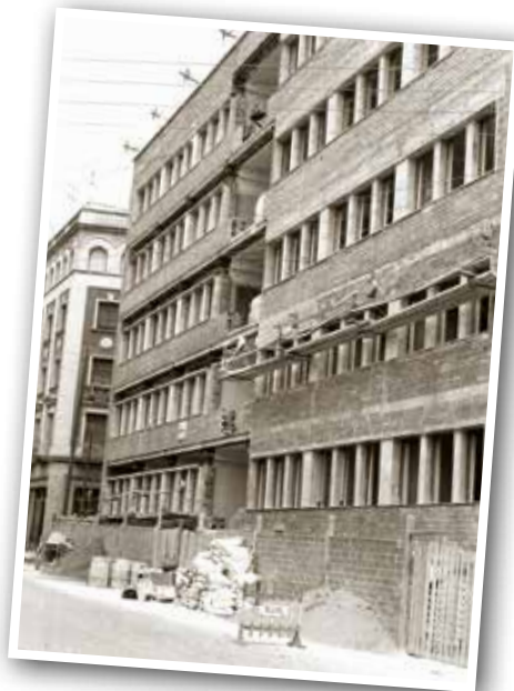
CONSTRUCCIÓ DEL CAP VALLÈS, ANY 1967. FOTO ANTONIO ALCALDE / REVISTA DEL VALLÈS / ARXIU MUNICIPAL DE GRANOLLERS
