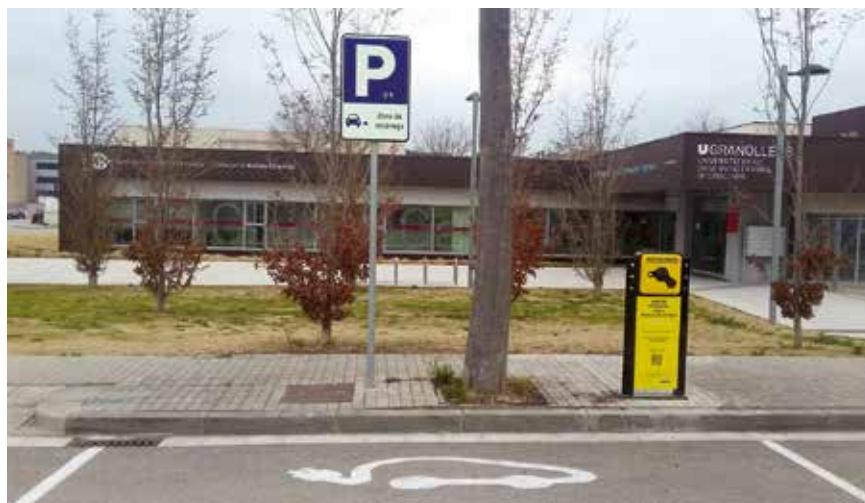
Punt de recàrrega per a vehicles elèctrics davant de Can Muntanyola. Centre de Serveis a les Empreses
