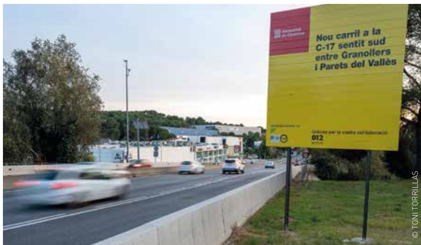
Obres d'ampliació del tercer carril de la C-17 a Parets del Vallès
