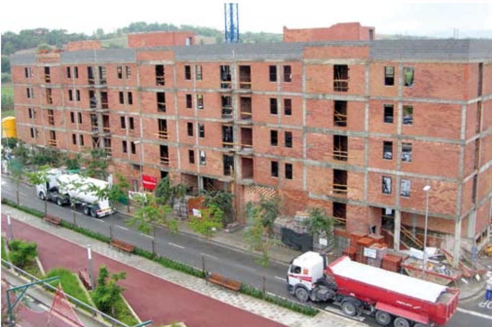
Construcció de 40 habitatges a l'av. Marie Curie, 26-32
