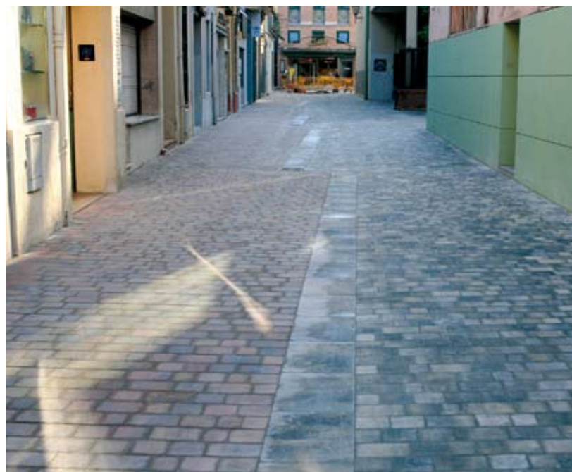
A l'esquerra, carrers i places abans de les obres. A la dreta, els espais renovats.
