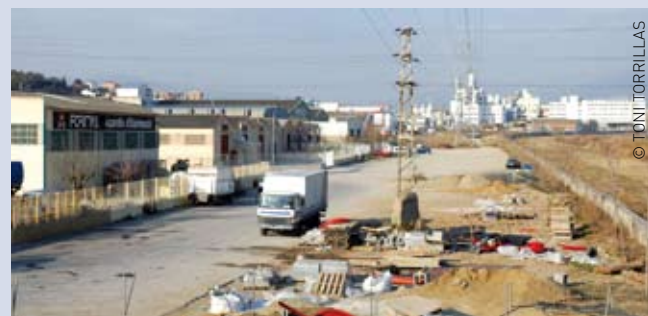
Imatge de l'estat de les obres el març de 2006
