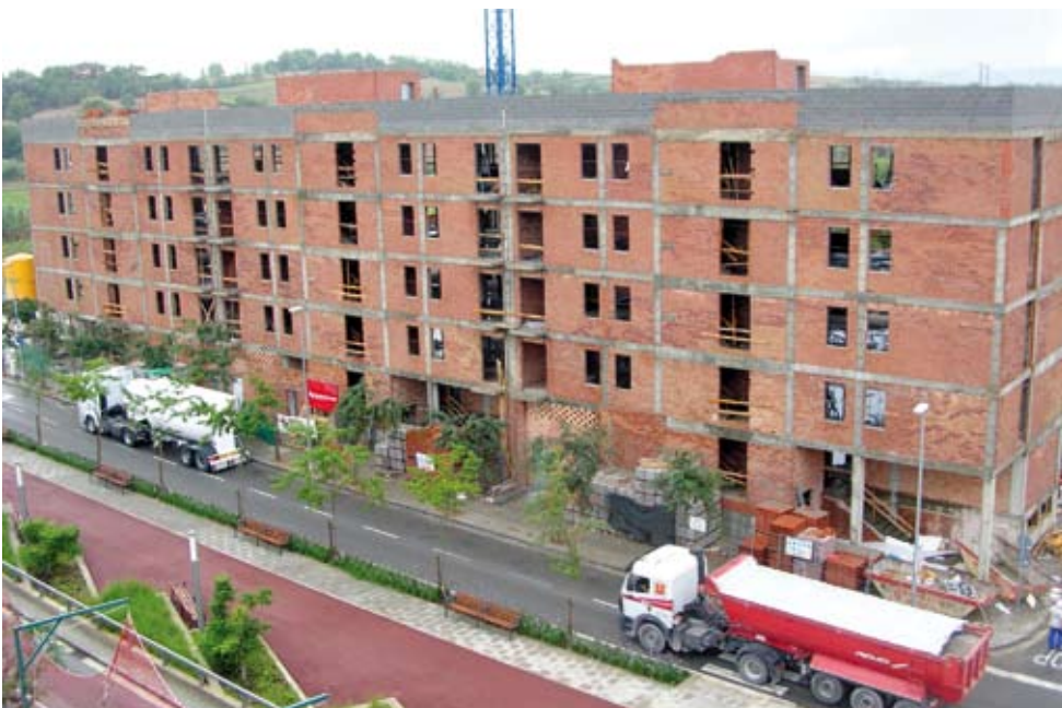
Construcció de 40 habitatges a l'av. Marie Curie, 26-32
