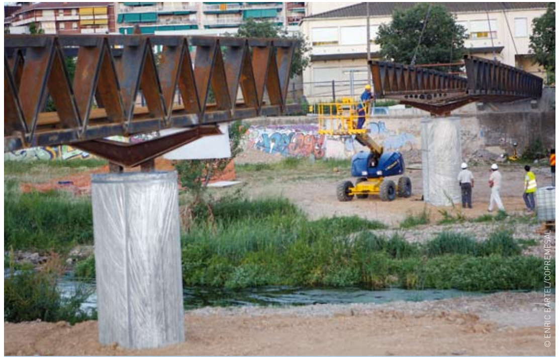
25 metres és la distància que falta per tenir l'estructura de la passera completa
