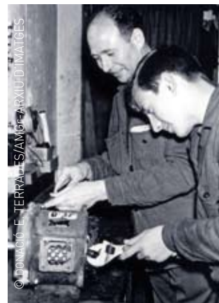
Esteve Terrades i Francisco Bermejo arreglant un motor a Roca Umbert. 1960
