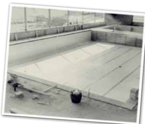
OBRES DE CONSTRUCCIÓ DE LA PISCINA MUNICIPAL COBERTA. AUTOR: JOAN MAS / FONS AJUNTAMENT DE GRANOLLERS / AMGR
