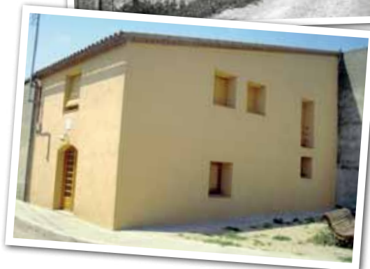
A DALT, L'ANTIC AJUNTAMENT DE PALOU ABANS DE LA REHABILITACIÓ DE L'EDIFICI QUE ES VA CONVERTIR EN CENTRE CÍVIC. FOTO: JOSEP NOGUÉS. A SOTA, DESPRÉS DE LA REHABILITACIÓ (1986). AUTOR I FONTS: PERE CORNELLAS/ARXIU MUNICIPAL DE GRANOLLERS
