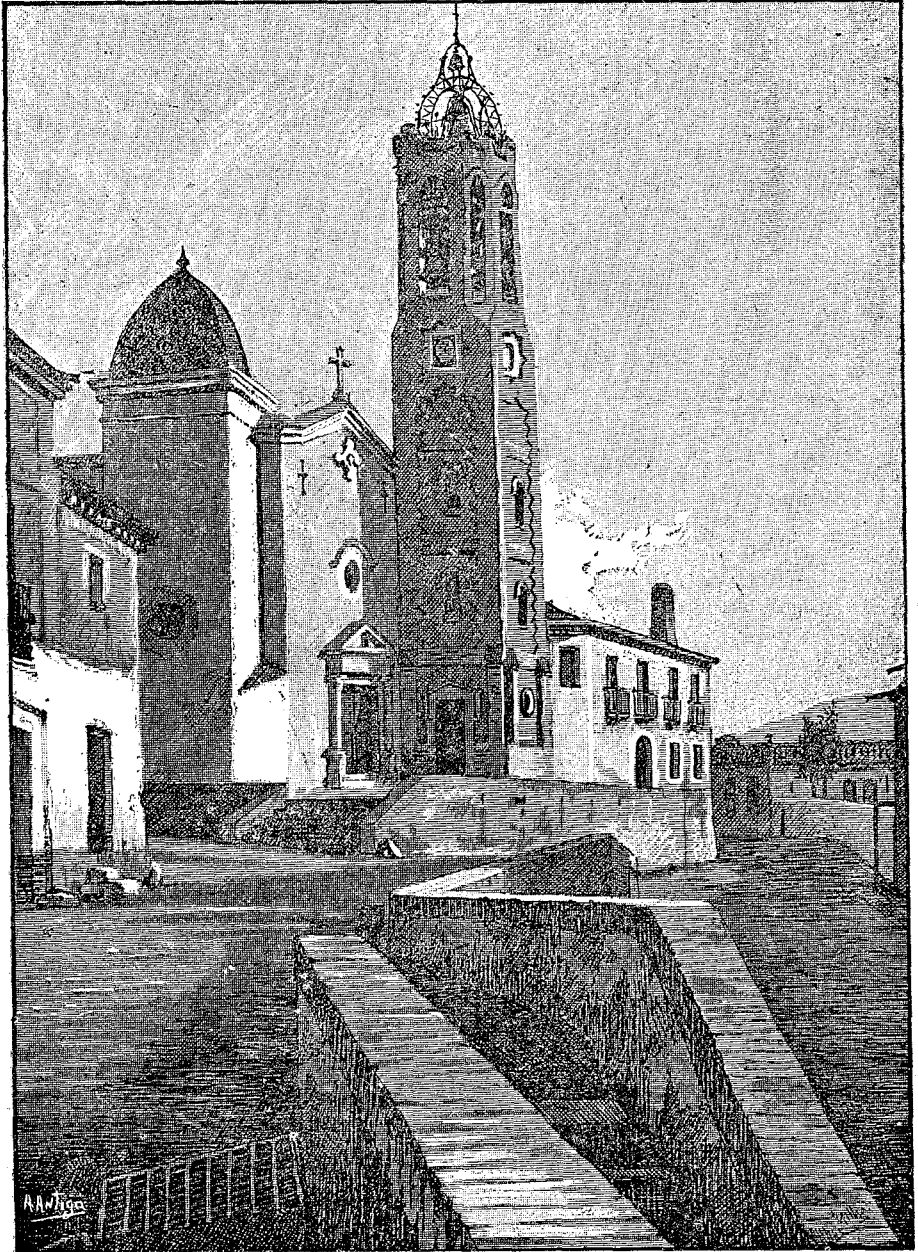
FRONTIS RESTAURAT Y NOU CAMPANAR DE SA IGLESIA PARROQUIAL
