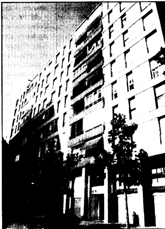
Edificio Mercè de Can Gili.
