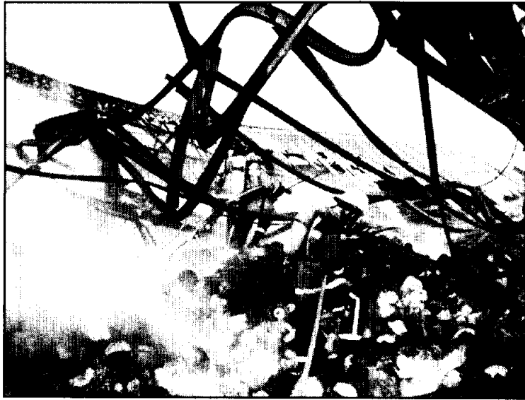
La estructura del almacén quedó deformada por la alta temperatura que alcanzó al arder el poliéster almacenado. GARCÍA
