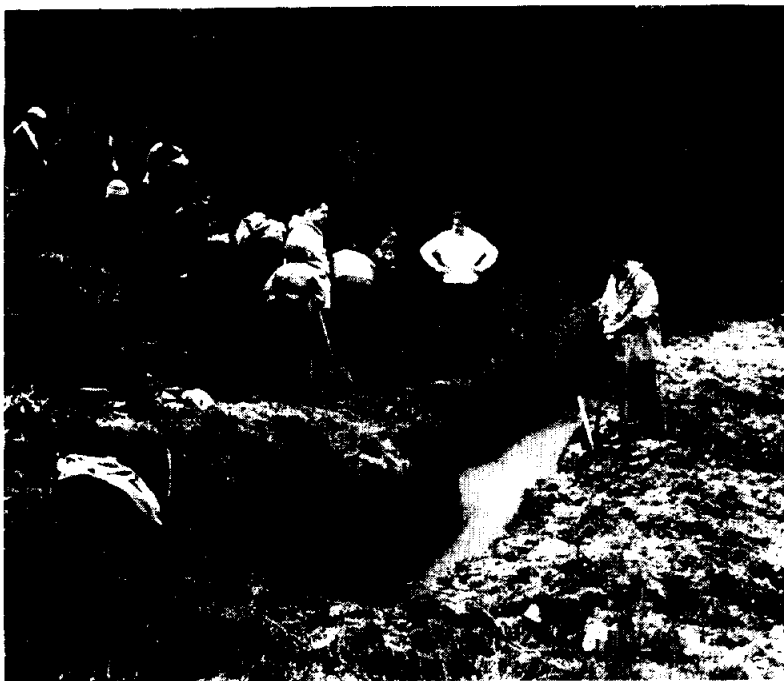
Treballs de construcció de la Font Pomereta.
