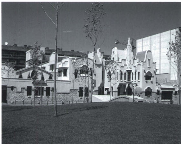
La Farinera Teixidor de Girona fou restaurada entre 1997 i 1999. A sota, dos detalls de la intervenció de Toni Cumella. (Fotografies: T. Cumella)
