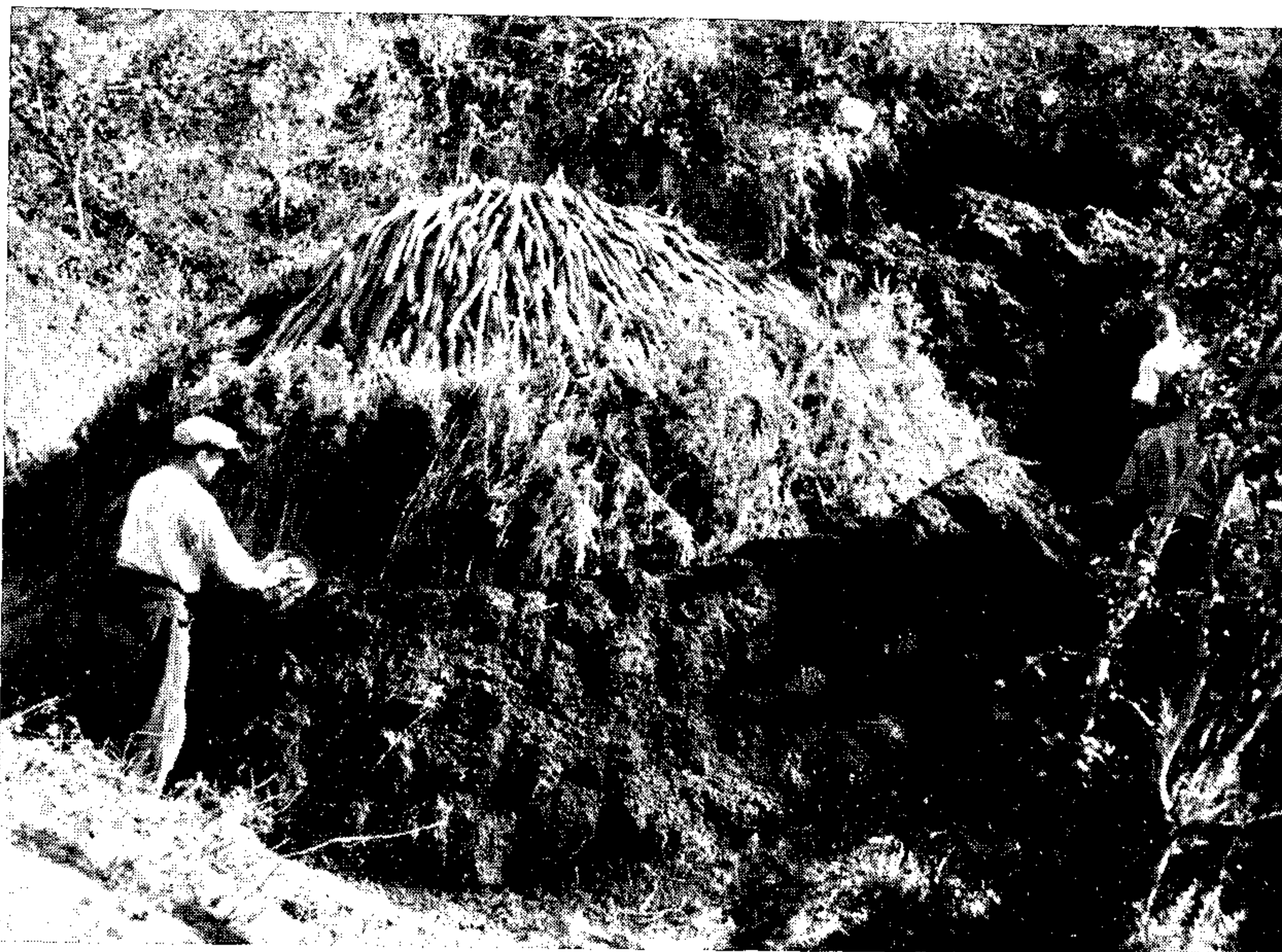
Les tres fases de la construcció d'una carbonera:
