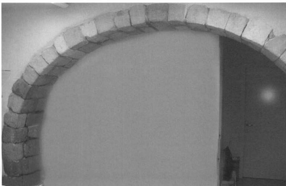
Arcada a l'interior de la casa de la plaça dels Cabrits núm. 5. (Fotografia: Pere Cornellas, setembre 2001)
