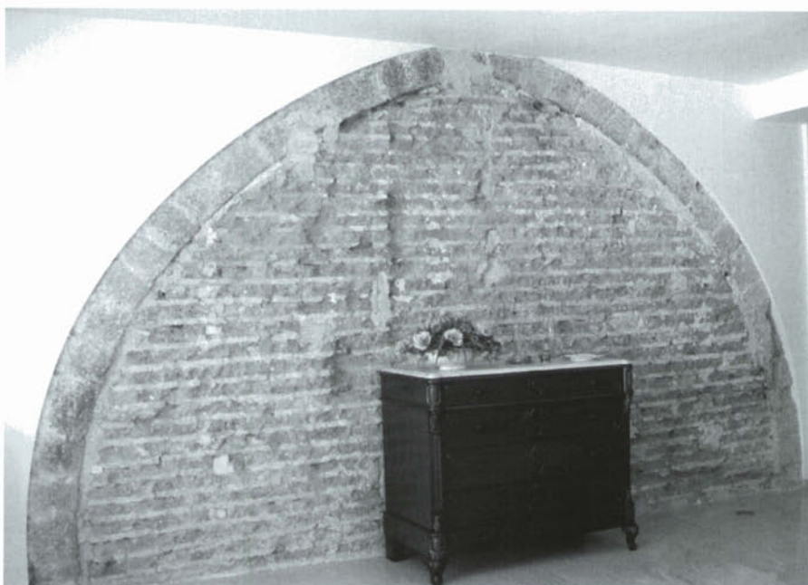
Arcada interior d'un habitatge del segle xv. Es va cegar amb un magnífic envà de tàpia. Plaça de les Olles núm. 14. (Fotografia: Pere Cornellas, gener 2002)
