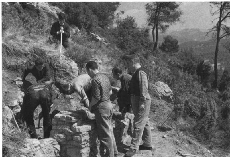
Josep Estrada dirigí els treballs de l'excavació al puig Dari, Sant Quirze Safaja, el 24 de març de 1963. (Fotografia: arxiu família Estrada)
