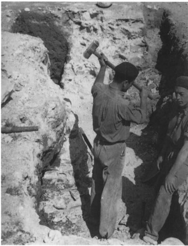
Excavació a l'antic fonament de l'església de Sant Esteve al costat oest del portal gòtic, maig de 1942.
