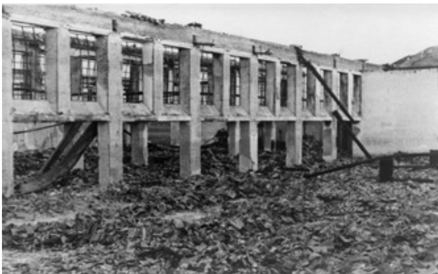
Estat de la fàbrica Roca Umbert al final de la Guerra Civil (fotografia: Josep Bosch / Fons Roca Umbert, 11-12-050517, AMGr).
