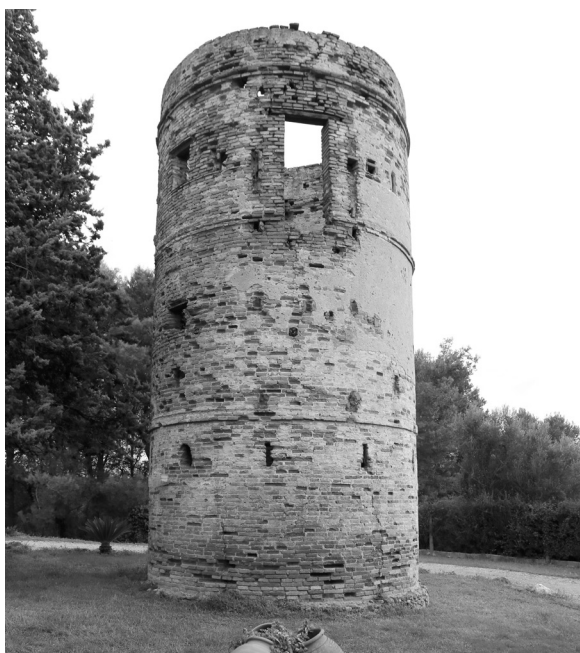
La torre de Can Casaca, de planta circular. Fotografia: Pere Cornellàs.
