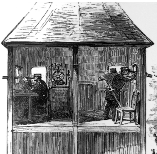
Gravat que representa el funcionament de l'observació de les torres col·laterals amb dos torrers. Font: tríptic «La telegrafia òptica. El telègraf de Montornès», Ajuntament de Montornès, 2013.
