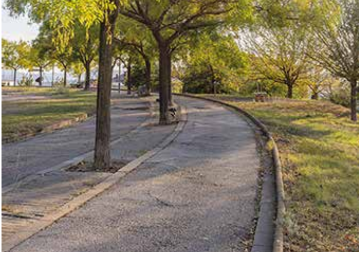
A l'esquerra, imatge actual d'un dels recorreguts del parc del Puig de les Forques. A la dreta, imatge virtual del camí, després dels treballs de millora
