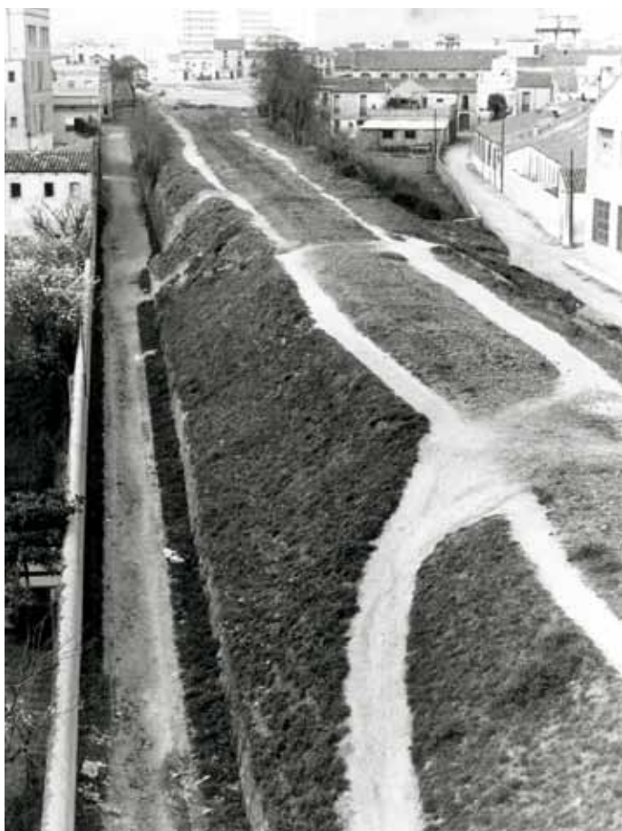
Terraplè de la via que passava per l'avinguda de Sant Esteve en el moment del seu desmantellament, 1962. Francesc Comas / Fons Ajuntament de Granollers / AMGr
