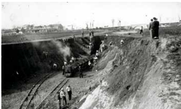
Obres de construcció de la nova línia del ferrocarril de França a l'alçada de la carretera de
