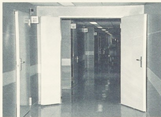
El sector aïllat per les portes de seguretat ofereix una resistència al foc de 60 minuts.
