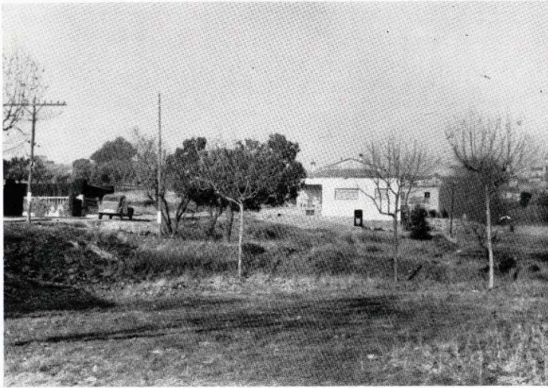
Otra vista parcial de la plaza del Ayuntamiento, antes de las obras de urbanización
