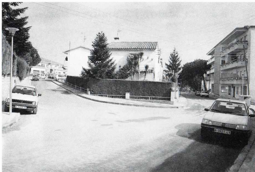
Els carrers de Can Torras amb la nova pavimentació
