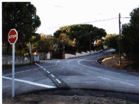
Nou asfaltat al camí del Serrat.
