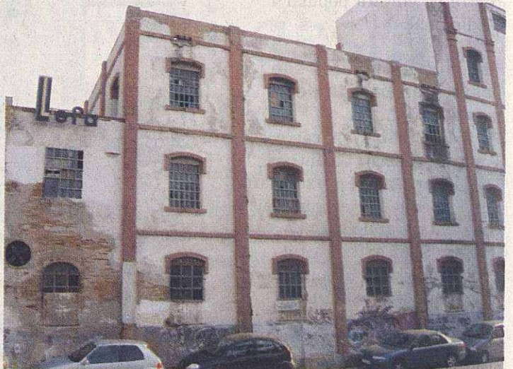
El edificio de Lefa podría pasar a manos del Ayuntamiento molletense
