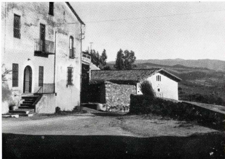
Vista del espacio que existía frente a la Casa Parroquial antes de las obras de urbanización
