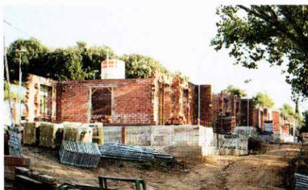
Els habitatges Socials en construcció.
