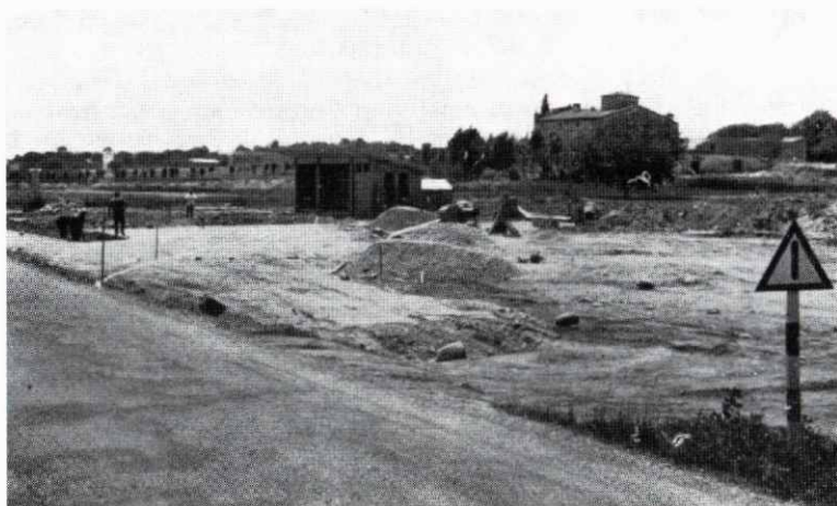
Obres per la instal·lació de l'Estació de Servei
