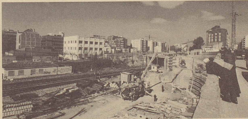
Ampliació del pont de la carretera de Mataró
