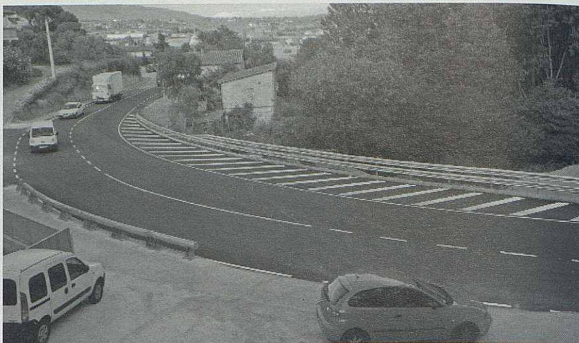
El pont de Can Baró després de les obres d'ampliació de la calçada.
