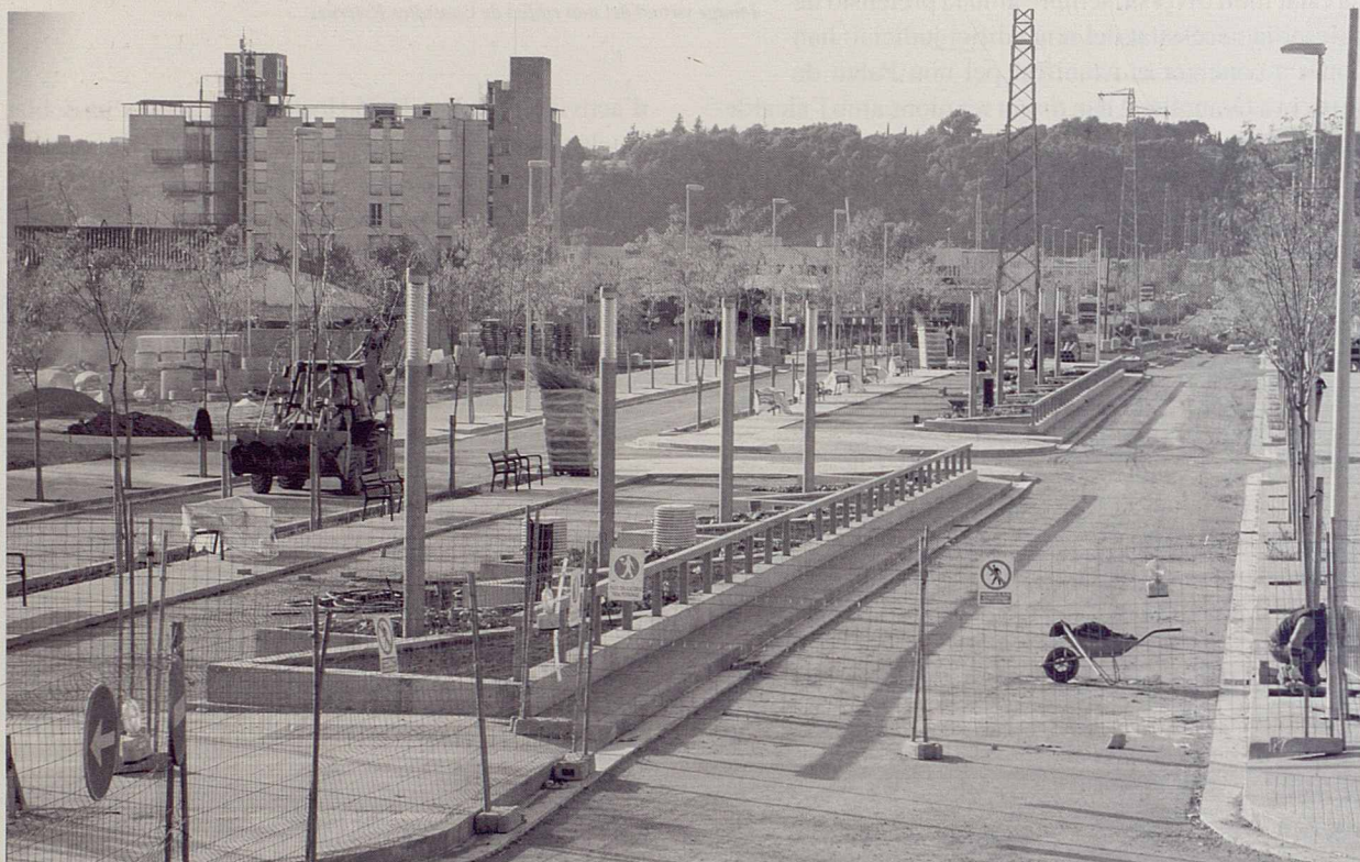
Obres d'urbanització al sector del Pla de baix. (Foto: Toni Torrillas)
