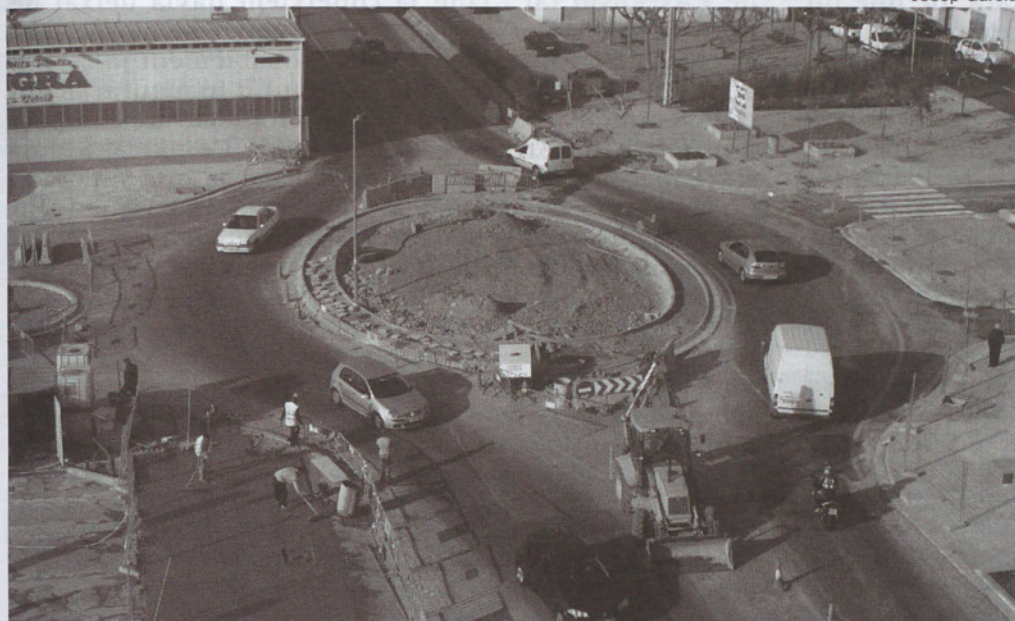
La nueva rotonda que se está construyendo en Palau, erca del Hotel granollers.
