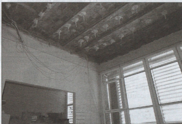
Estado en que quedó la secretaría de la Escola del Treball tras el hundimiento del falso techo.
