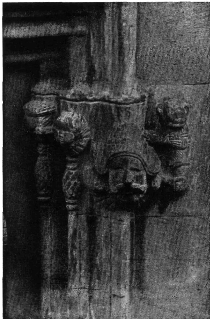
Detall de la finestra del segle XVI, avui balcó de transició al Renaixement, al carrer del Doctor Riera. Fot. Canal
