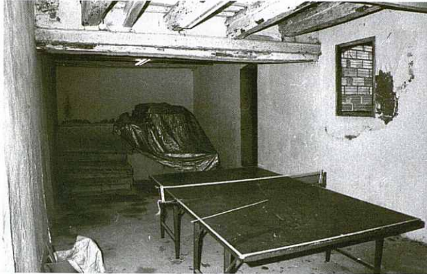
Aspecte actual de la planta baixa on s'ubicarà la futura sala d'exposicions de l'AEG. Fotografia: Jordi Icart
